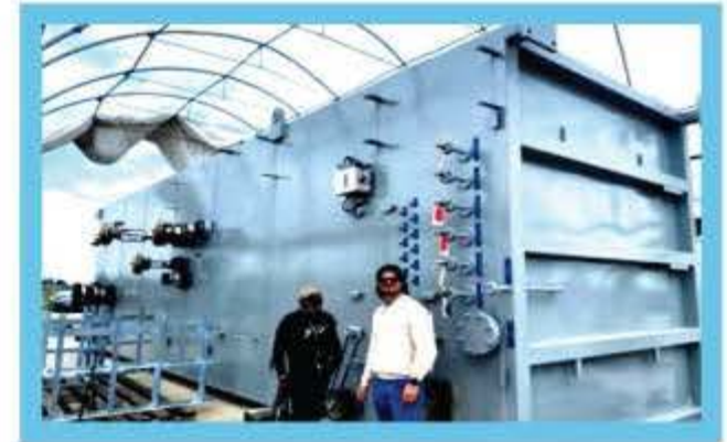
LNG Cold Box Column Under Construction
